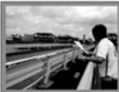
生まれ変わる吉川橋
